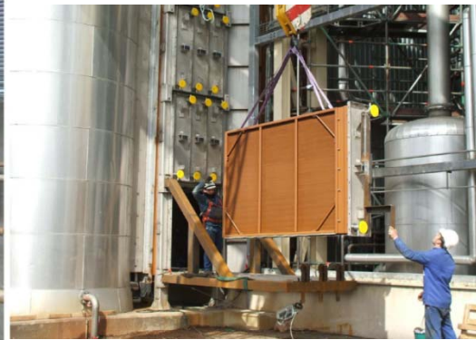
Echangeur type Batteries à ailettes: traitement de surface anticorrosion
